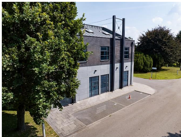
Budynek B (dyżurka)
